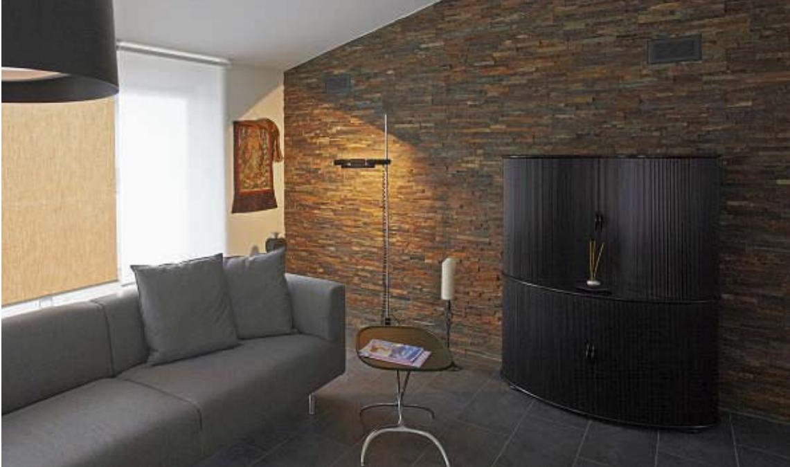
↑ Die Innenseite der Passivsolarwand, die die passive Sonnenenergie speichert.
