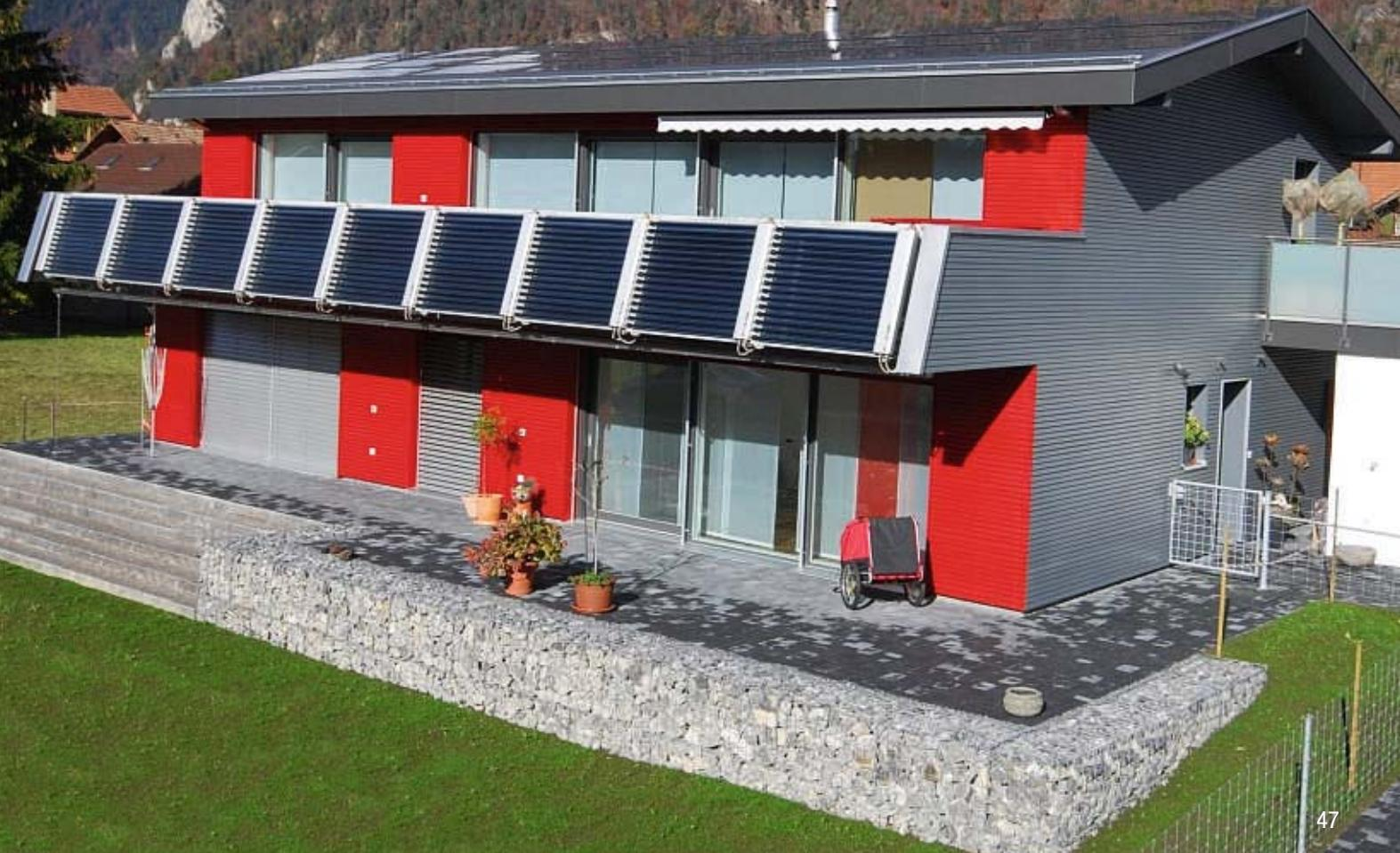
↑ Sonnenkollektoren an der Balkonbrüstung decken den Warmwasserbedarf für das ganze Jahr.
