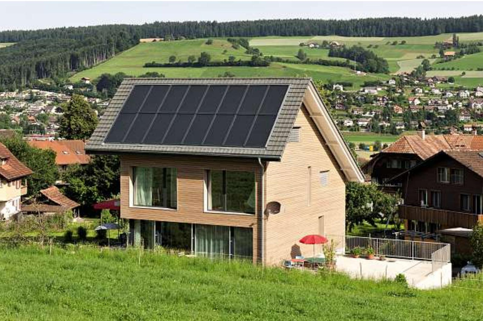
das Ehepaar Iseli ganz bewusst für eine Solar/Holzheizung im neuen 5.5-Zimmer-Minergie-P-Einfamilienhaus. Die Heizung besitzt einen grossen Speicher, der in den kältesten Monaten manuell eingefeuert werden muss.
