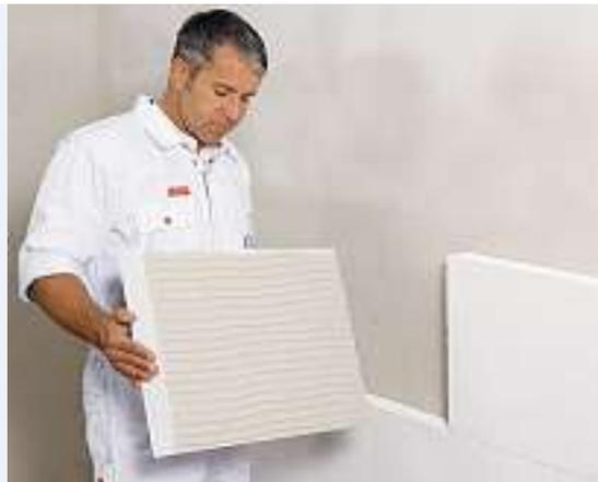
Kleber vollflächig auf Mineraldämmplatte auftragen.
