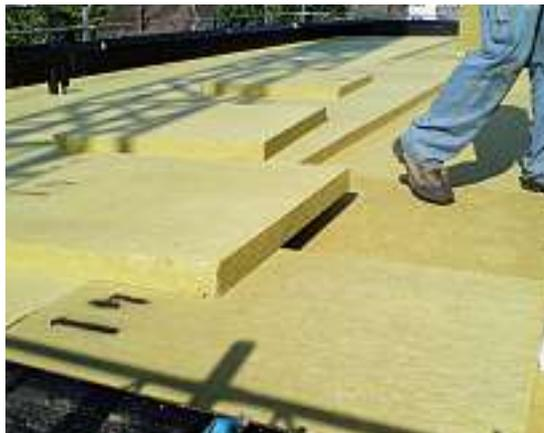
Für ein einfaches und wirtschaftliches Verlegen ist jede Flumroc-Gefälledachplatte beschriftet und mit einer Verlegerichtungsmarkierung versehen.
