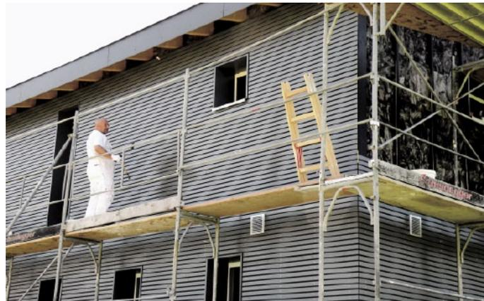
Mit dem Fassadensystem Phoenix Facade konnte bei einer Dämmstärke von «nur» 28 cm, ein U-Wert von 0,1 W/m<sup>2</sup>K erreicht werden.
