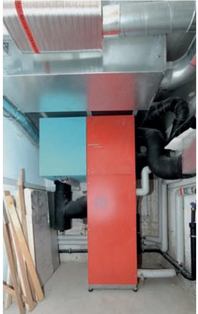
Kompaktgerät: versorgt das Haus mit Frischluft und Heizwärme.
