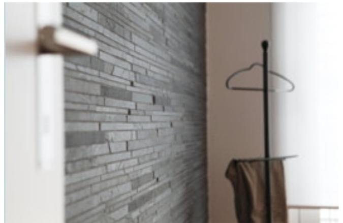
Die Wand wurde aus vielen, bloss rund 3 cm hohen, leicht versetzt aufeinander gelegten Platten errichtet: «Durch diese Staffelung ist die Oberfläche etwa zweieinhalb Mal grösser als wenn sie glatt wäre – so kann mehr Wärme aufgenommen werden», erklärt Wegmüller. Bei einer so dicken Dämmung und grossen Speichermasse muss dafür im Sommer der Sonnenschutz funktionieren. Da dann die Strahlung steil auf das Haus fällt, schützen die Auskragung des Daches das obere Stockwerk
